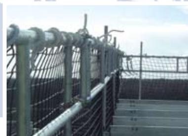
***Atteignez une plus grande sécurité et efficacité aux chantiers de construction par l'usage de filets de sécurité contre la chute.***
